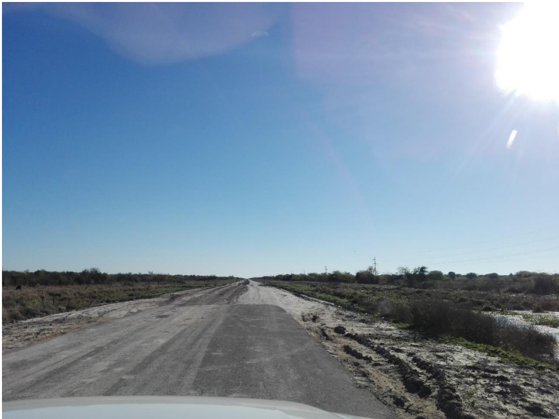
RP nº 3 sin pavimentar, camino desde Intiyaco a Los Tábanos
