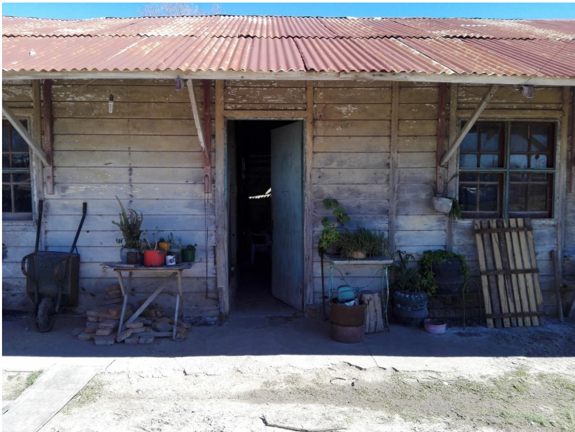
Casilla donde inicialmente se constituyó el CAPS. Los Tábanos
